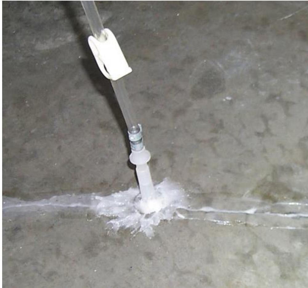
Injectare sub presiune cu mortar epoxidic
