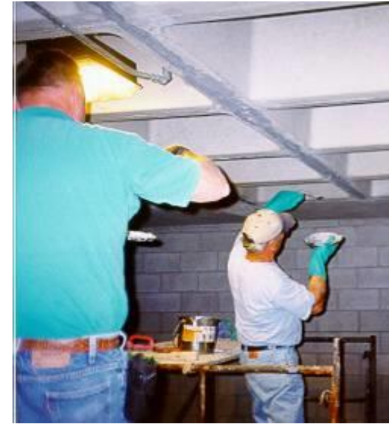
Aplicarea adezivului pe lamelă
