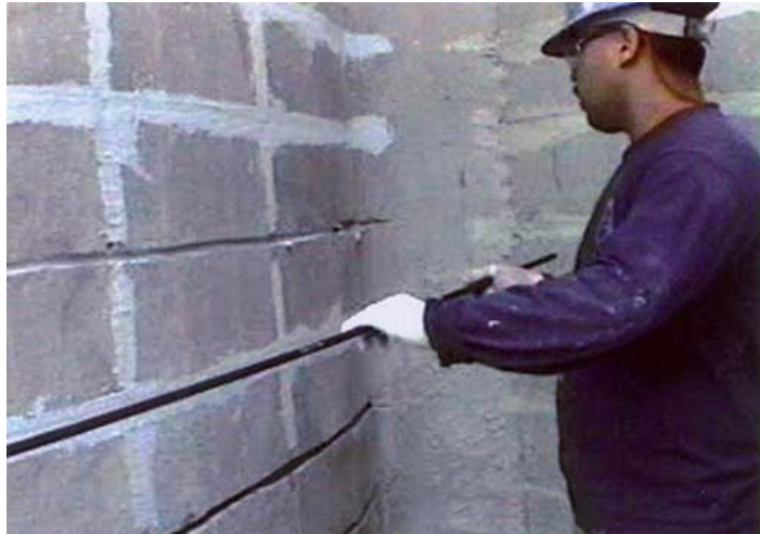
Instalarea armăturilor în pastă de rășină
