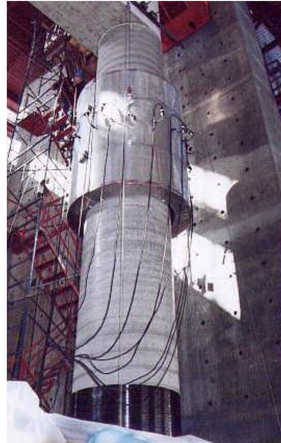
Tratarea termică a suprafeței consolidate
