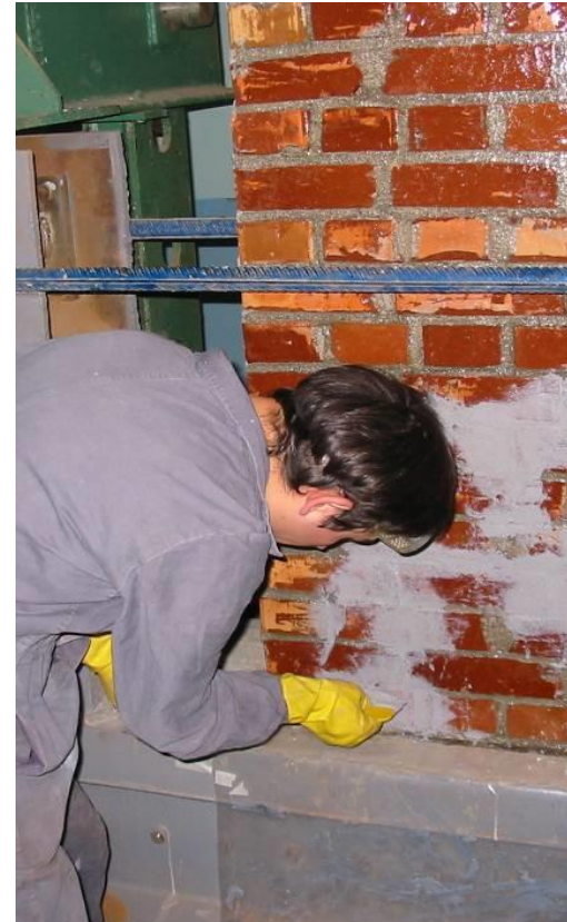
Aplicarea mortarului de corectare
