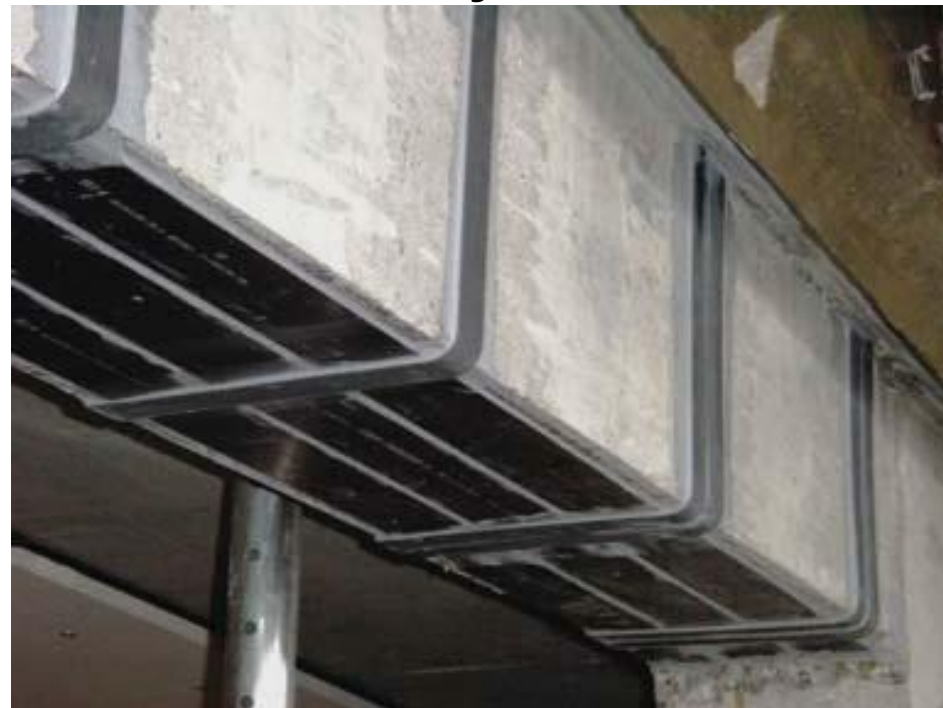
CONSOLIDARE LA FORFECARE ȘI ÎNCOVOIERE
