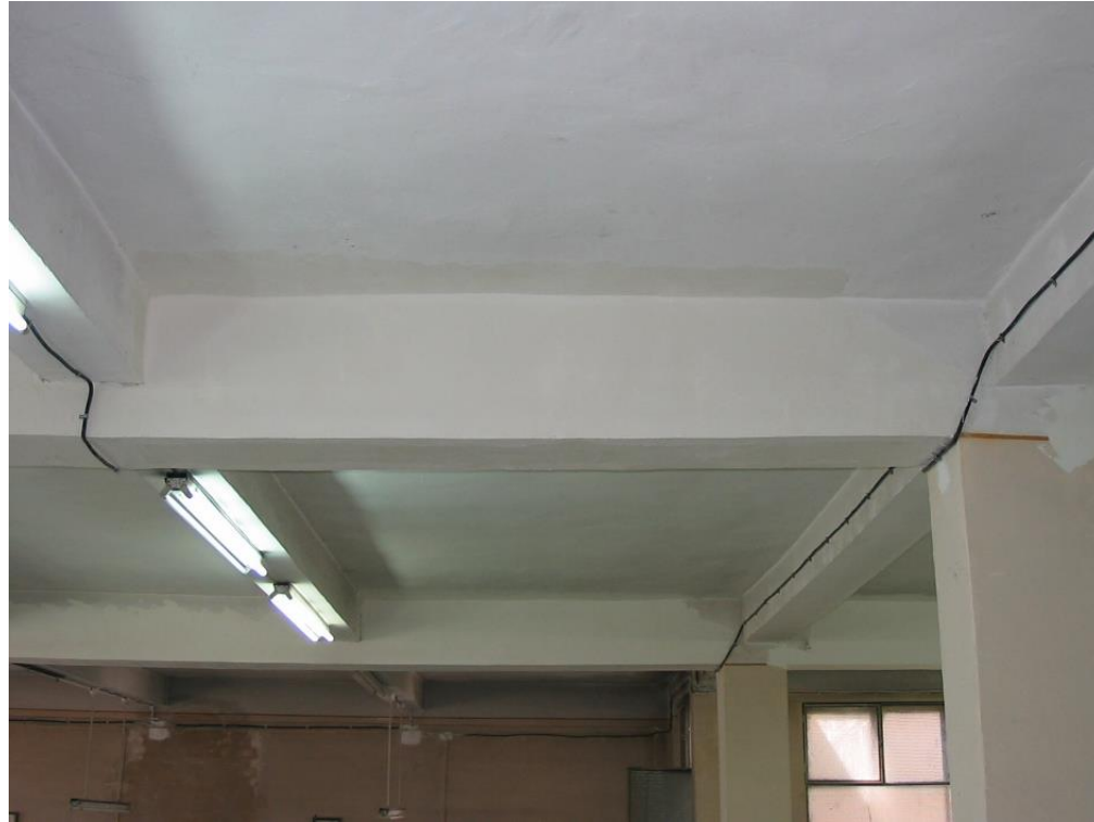
Aplicarea stratului de acoperire sau de protecție
