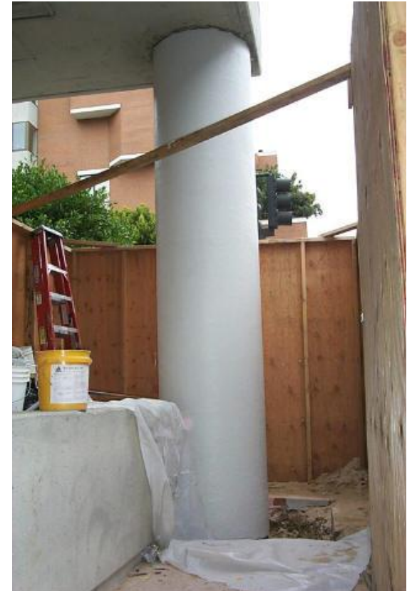
Aplicarea stratului de acoperire (protecție)
