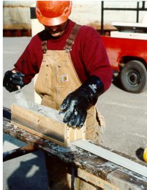
Aplicarea adezivului pe lamelă
