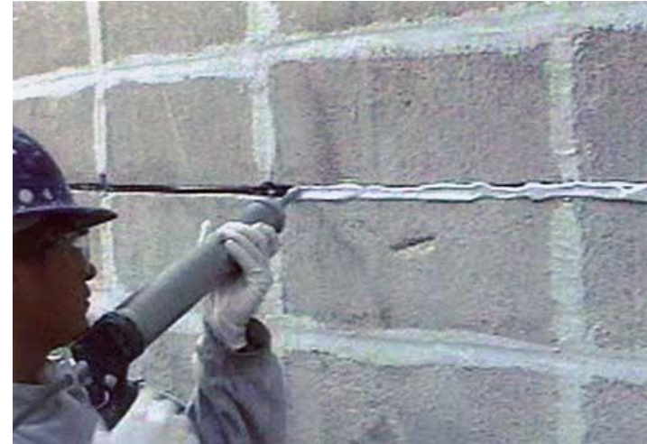
Aplicarea rășinii de acoperire
